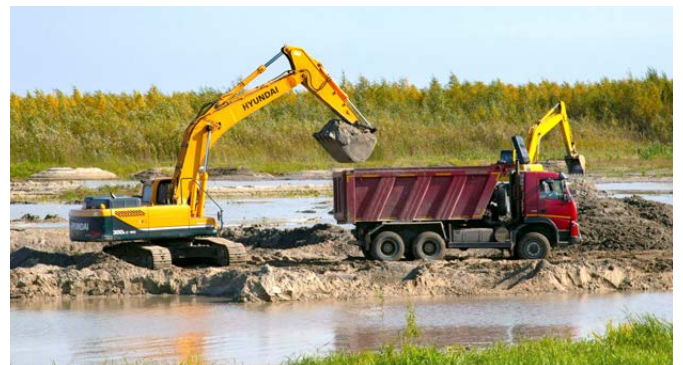
Figuur 1: Grondverzet voor rivierverruiming.
